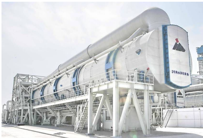
图 2.1.2 神华河北国华沧东发电有限责任公司 12500m 3 /d MED 装置
