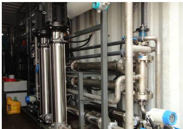
图 1.12.2 能量回收装置在纳滤海水淡化工程的应用（青岛）
