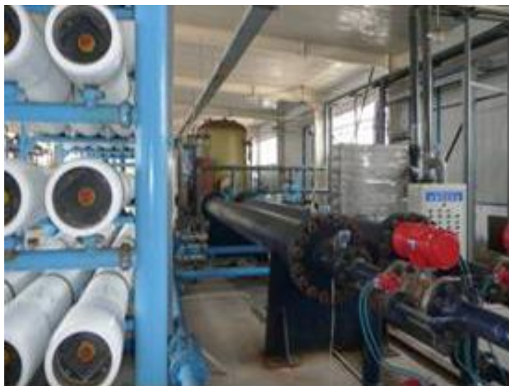
图 1.12.1 天津塘沽 1000 m 3 /d 反渗透海水淡化能量回收装置示范现场
