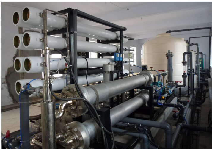
图 1.14.4 差动式能量回收装置图
