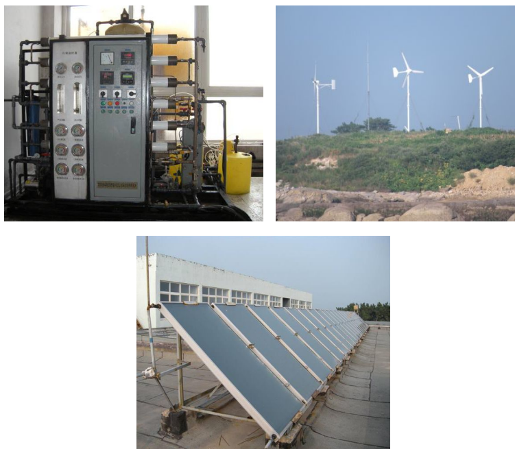
图 1.3.2 大管岛 5m³/d 海水淡化工程
