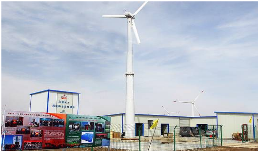
图 3.4.4 非并网风电海水淡化系统示范基地全景
