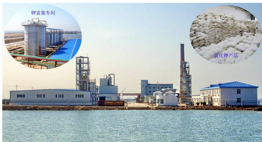
图 4.3.5 1 万 t/a 海水直接提取氯化钾试验厂
