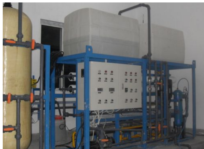
图 1.14.2 25m 3 /d 海岛节能型海水淡化装置
