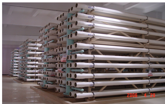
图 1.1.10 反渗透膜堆
