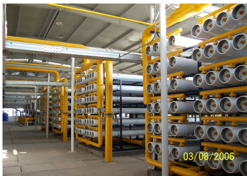
图 1.5.7 反渗透除盐系统
