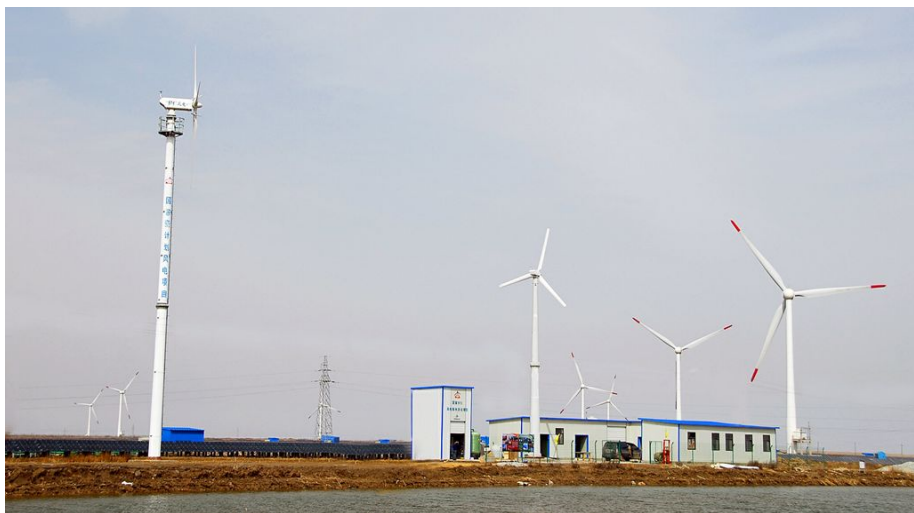
图 3.4.2 非并网风电日产 100 吨海水淡化系统大丰示范基地现场图
