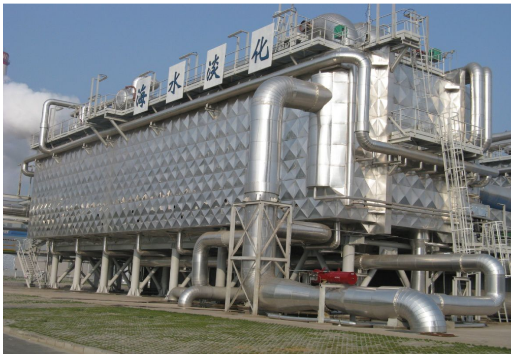
图 2.3.2 首钢京唐公司 2 \times 12500 \text{m}^3/\text{d} 海水淡化装置图
