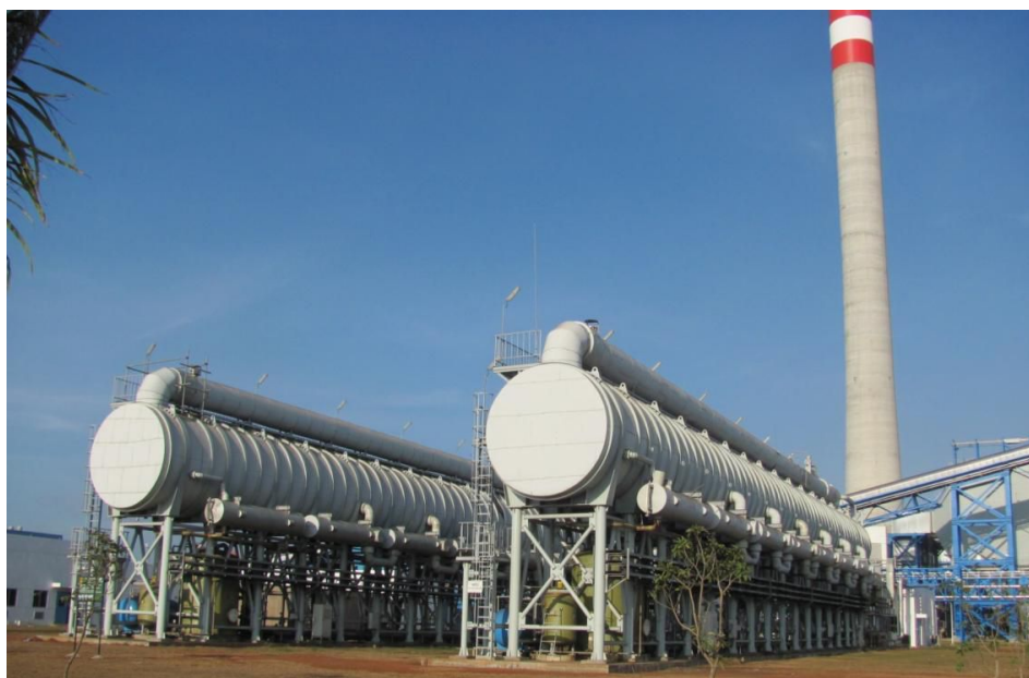
图 2.2.2 印尼英德拉玛尤 2 \times 4500 \text{ m}^3/\text{d} MED 海水淡化工程
