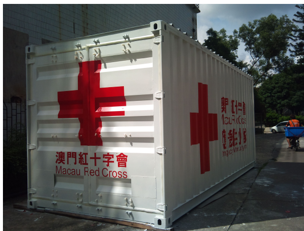
图 1.4.1 澳门红十字会集装箱应急供水设备
