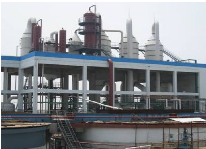
图 4.3.4 蒸发分离系统装备
