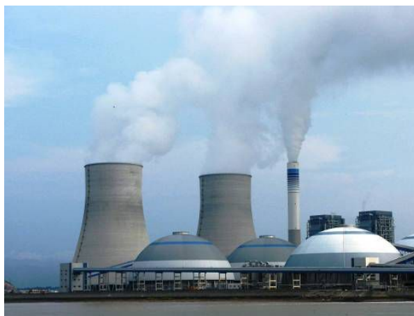
图 4.1.2 浙江宁海电厂 2 \times 10 万 \text{m}^3/\text{h} 海水循环却示范工程
