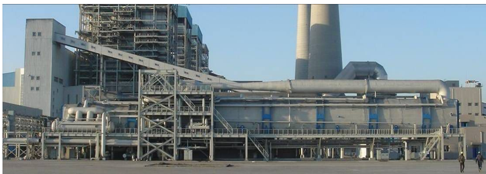
图 2.5.3 河北黄骅电厂 1.25 万 \text{m}^3/\text{d} MED 海水淡化装置
